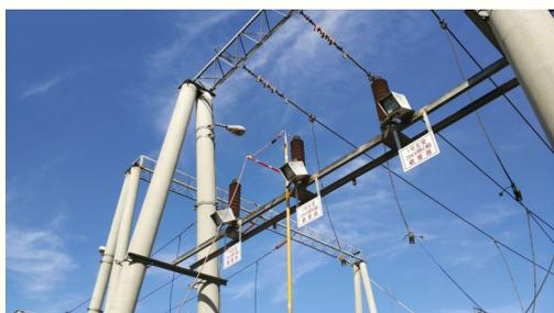
图9 避雷器停电试验接线辅助装置现场使用图
