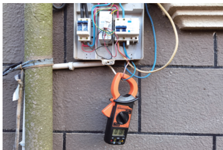
图2 一路表后线存在漏电电流1.8 A
